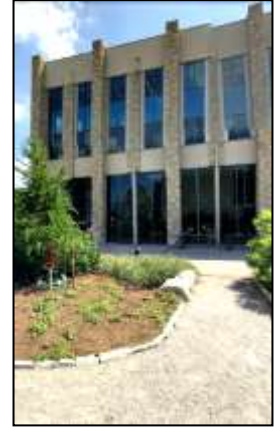
شكل (29) مبنى كلية الهندسة، جامعة ويسترن، كندا، المصدر: Google Map
